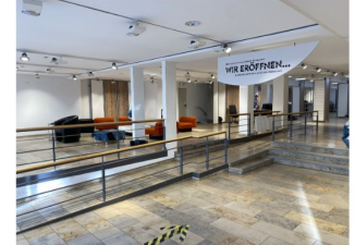
Umbau und Sanierung können beginnen, damit das ZAM durchstarten kann. Foto: Conrad Heise (Büro/beweb)
