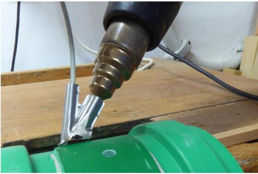
Eine Temperatur-geregelte Heissluftpistole liefert die für **PP** erforderliche Temperatur von **300 °C**, bei der das Trägermaterial und der Schweißdraht schmelzen und sich miteinander verbinden.
