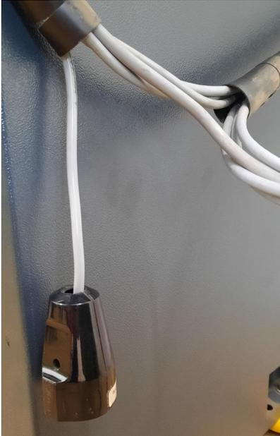
Die Steckdose ist über die Steuer-Elektronik und Schrittmotor-Treiber angeschlossen sein, und kann durch den Notaus stromlos geschaltet werden.
