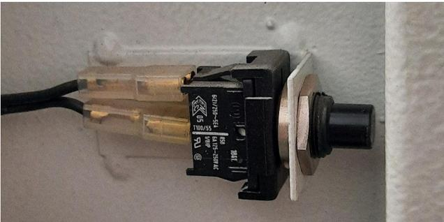
4. **Steckdose** - aus dem Bedienpanel hängt an einem Kabel eine herausgeführte Steckdose. Diese ist nicht über Relais geschaltet, wird aber durch den Notausschalter ausgeschaltet.
